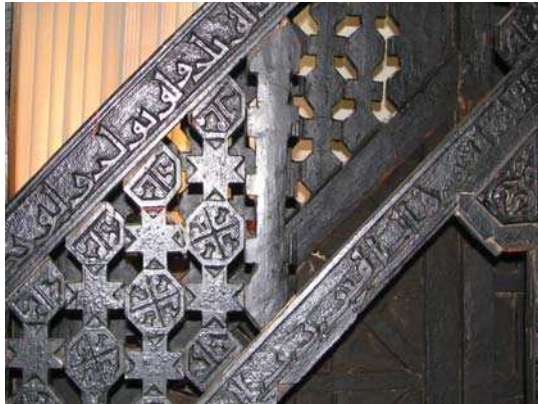
تصویر ۱۶- نمایی نزدیک از تزئینات مشبک و مرمت ناشیانه با چوب صنوبر در سمت چپ منبر مشکول، ماخذ: همان
