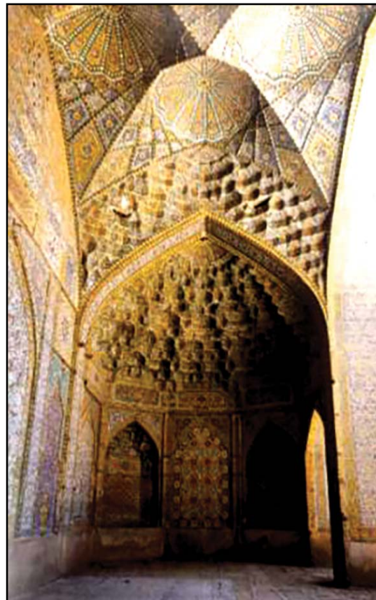
تصویر ۸. ایوان شمال شرقی (حاجی‌قاسمی، ۱۳۸۲، ص. ۱۱۴) Figure 8. Northeastern Iwan (Haji-Qasemi, 2003, p. 114)
