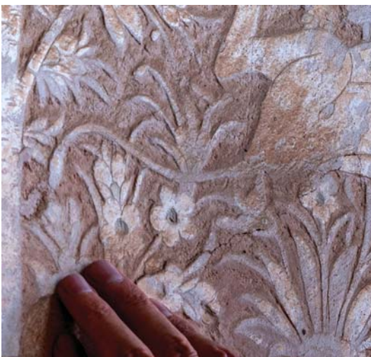
تصویر ۵. کشته‌بری خانه پیرنیا با اختلاف سطح کمتر از یک میلی‌متر که عمل برش و کندن انجام شده است.
