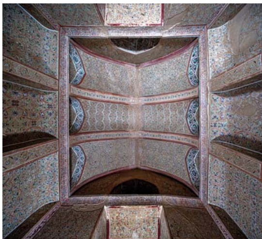
تصویر ۱. نمایی از آرایه گچی کشته‌بری طبقه پنجم کاخ عالی‌قاپو، (محمودی از ناوه، الف، ۱۴۰۲)
