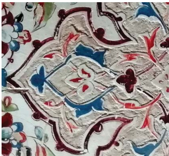
تصویر ۶. کشته‌بری کاخ عالی‌قاپو با اختلاف سطح کمتر از یک میلی‌متر که عمل برش، کندن و پرداخت انجام شده است.
