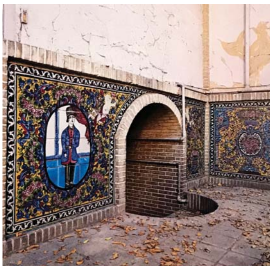
تصویر ۲. کاربرد کاشی در ازاره دیوارهای حیاط خانه صادق هدایت، مأخذ: نوروزی طلب، ۱۳۹۵: ۱۸۶
