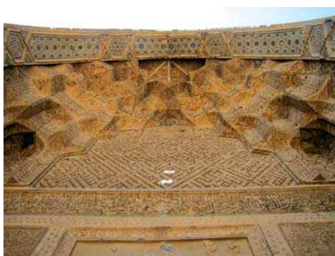
تصویر ۲۱. کتیبهٔ آجری به خط بنایی در ایوان جنوبی مسجد ورامین، مأخذ: همان.
