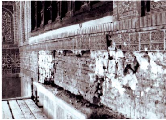
تصویر ۴. برداشتن قسمتی از کاشی‌های کتیبه سردر مدرسه خان در سال ۱۳۶۷ و نصب مجدد آنها پس از جازنی و زیرسازی با استفاده از تورفلزی و سیمان زبره، مأخذ: کمالی پور، ۱۳۶۷.
