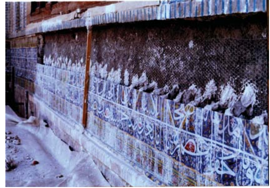
تصویر ۴. برداشتن قسمتی از کاشی‌های کتیبه سردر مدرسه خان در سال ۱۳۶۷ و نصب مجدد آنها پس از جازنی و زیرسازی با استفاده از تورفلزی و سیمان زبره، مأخذ: کمالی پور، ۱۳۶۷.
