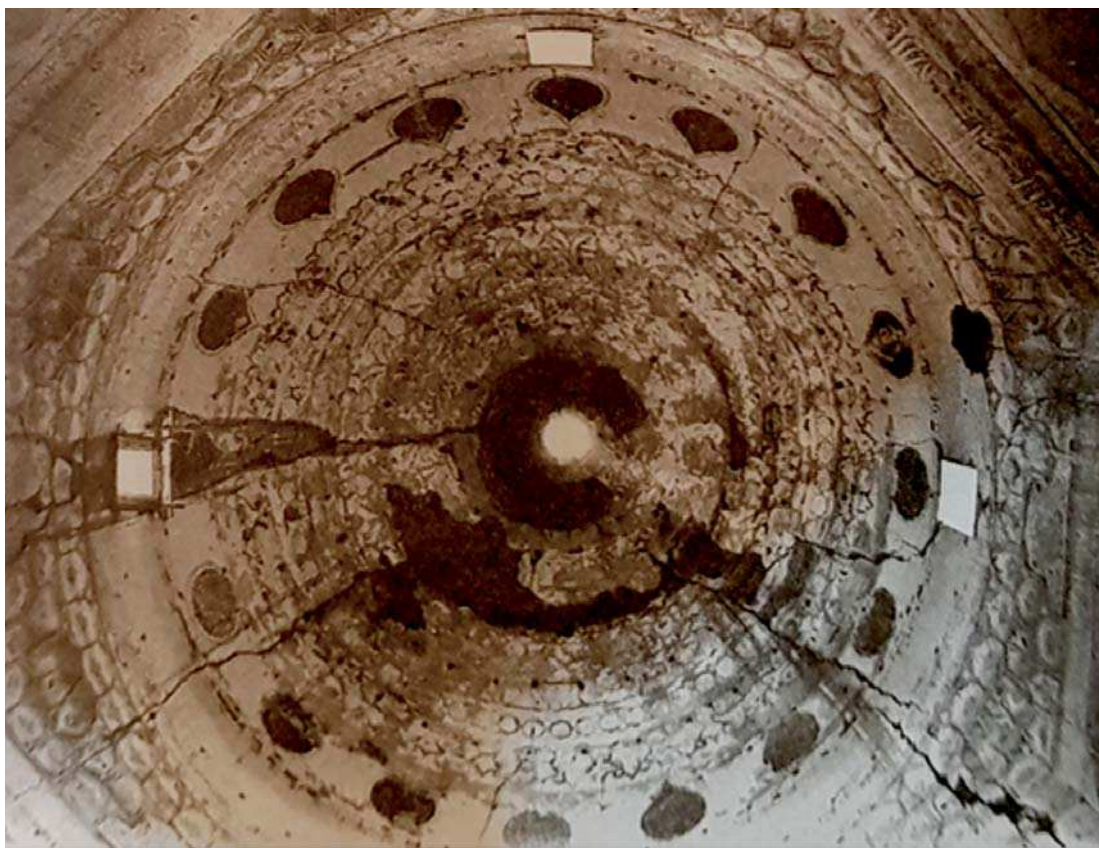
ارتباط معنوی عدد اجدد ۱۱۰ نام مبارک امام علی (ع) در شکل‌گیری ارتباط معنوی مراتب هستی در گنبد سلطانیه. مأخذ: نگارندگان.
