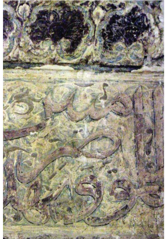
تصویر ۲۲. بخشی از تزیینات وصله‌ای گچ، گنبد سلطانیه. نقش گل نیلوفر باز در قسمت فوقانی تصویر، قالبی و خطوط ثلث تحتانی دستی اجرا شده‌اند. خطوط ثلث روکشی از گل سرخ دارند که احتمالاً با لایه‌ای از طلا پوشیده بودند.
