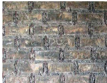
تصویر ۲. گنبد سلطانیه، تکنیک کلوک‌بند در دیواره داخلی طبقه بالا.
