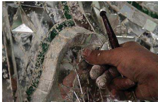
تصویر ۱۰. نصب قطعات آینه، مأخذ: www.Shbestan.ir
